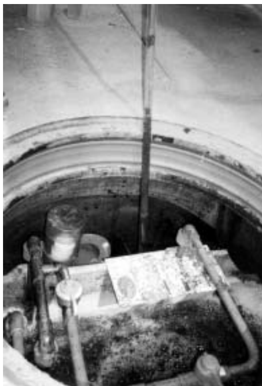
(透明アクリル管にて処理水槽の堆積汚泥を測定している写真)
